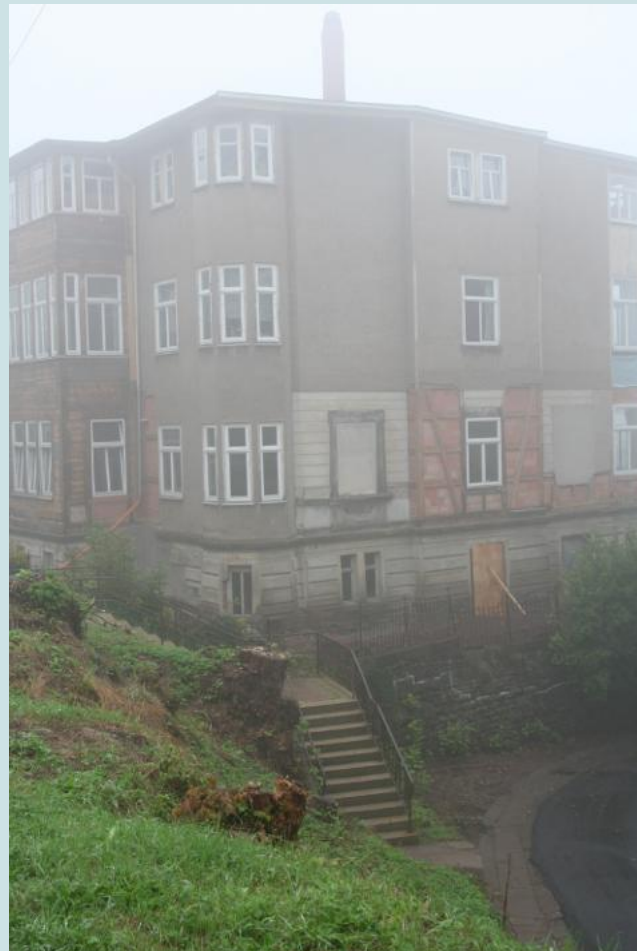
Treppe & Herzogsweg 16 vor Sanierung
