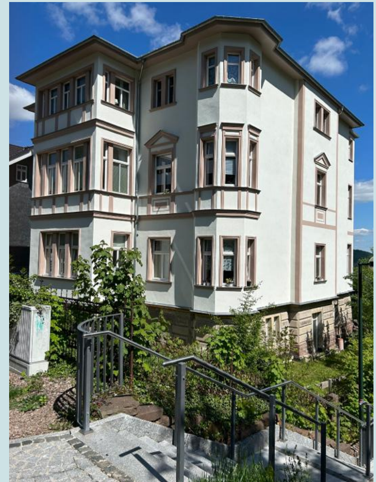
Treppe & Herzogsweg 16 nach Sanierung
